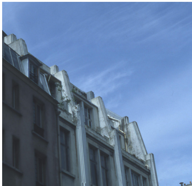
2: Rue des Plantes 26, obere Stockwerke
